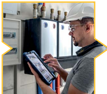
Abnahme durch Elektro-Meister
